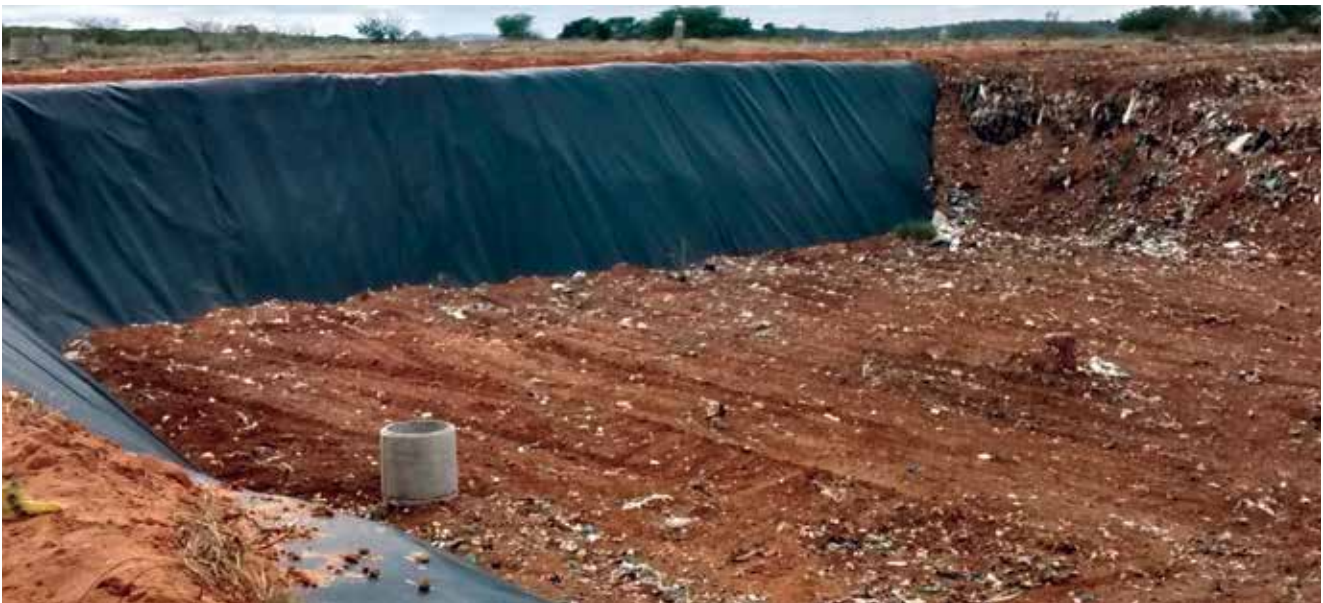
Foto 4. Vala para disposição dos resíduos no aterro em Brejo Santo
