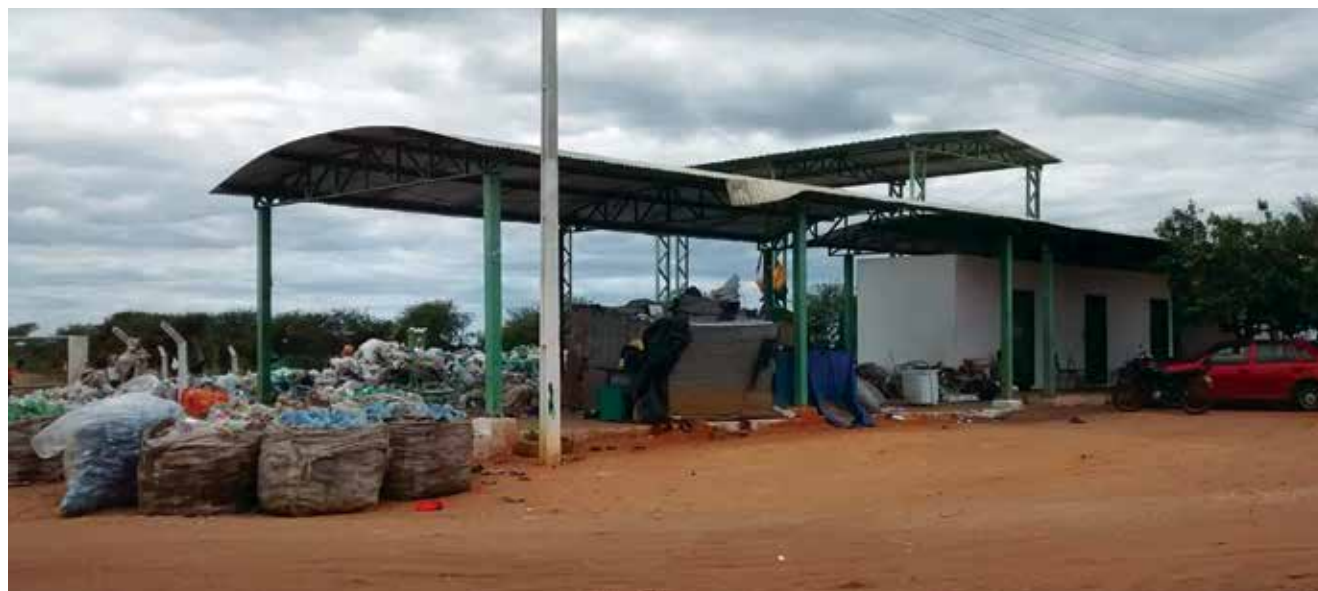
Foto 6. Galpão de triagem no aterro de Brejo Santo
